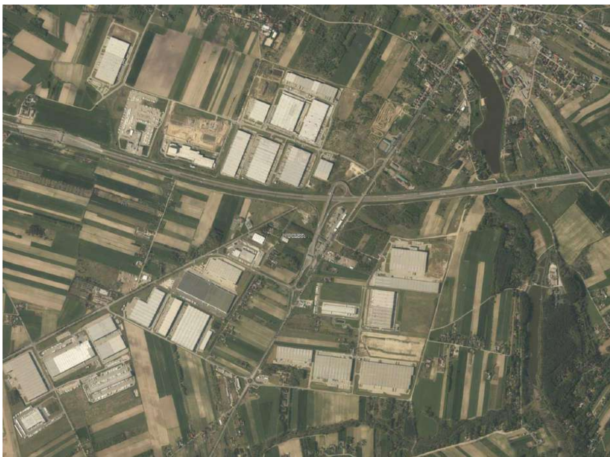
Rysunek 5. Strefa logistyczna przy drogach A2 i DK14 (węzeł Stryków) na terenie gminy Stryków
